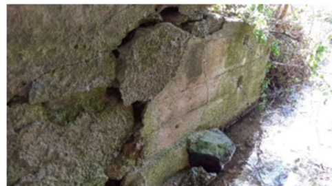
Fracture et basculement de l'angle piedroit / mur amont rive droite
