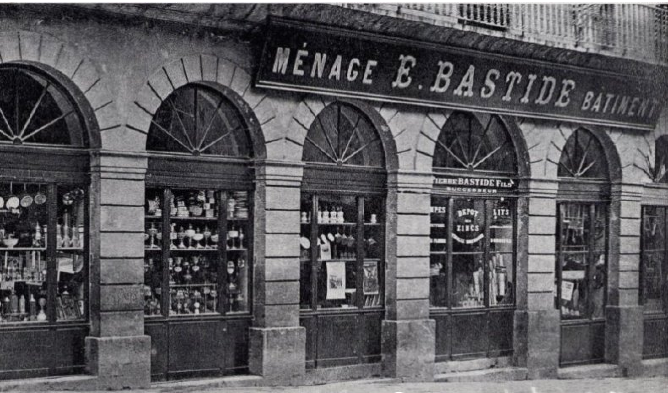
Rodez - rue du Bal, la maison Bastide et sa suite d'arcades, un des vieux magasins du quartier
