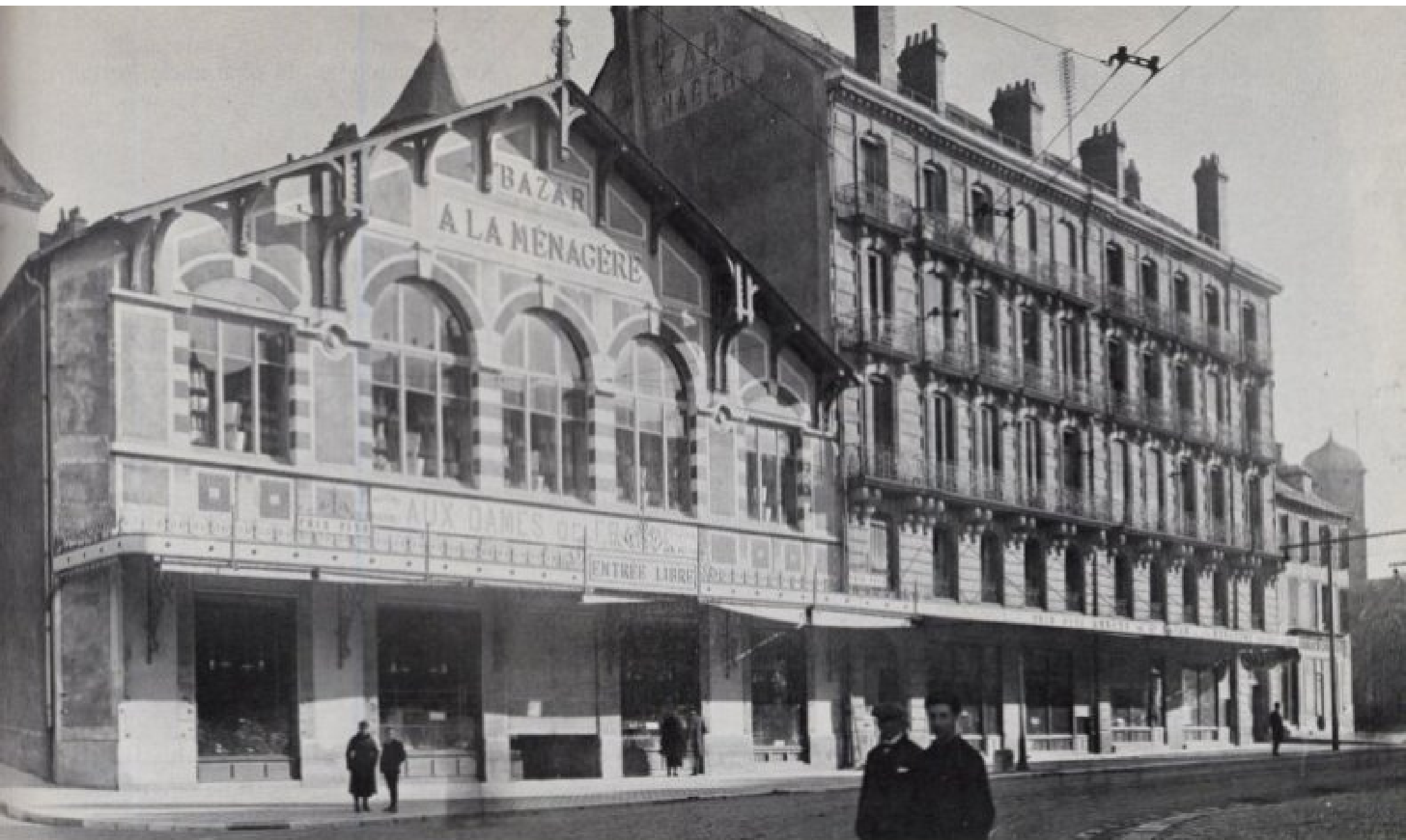
Rodez - boulevard Gambetta, les grans magasins "A la Ménagère" deviendront "les Dames de France" puis "Monoprix"
