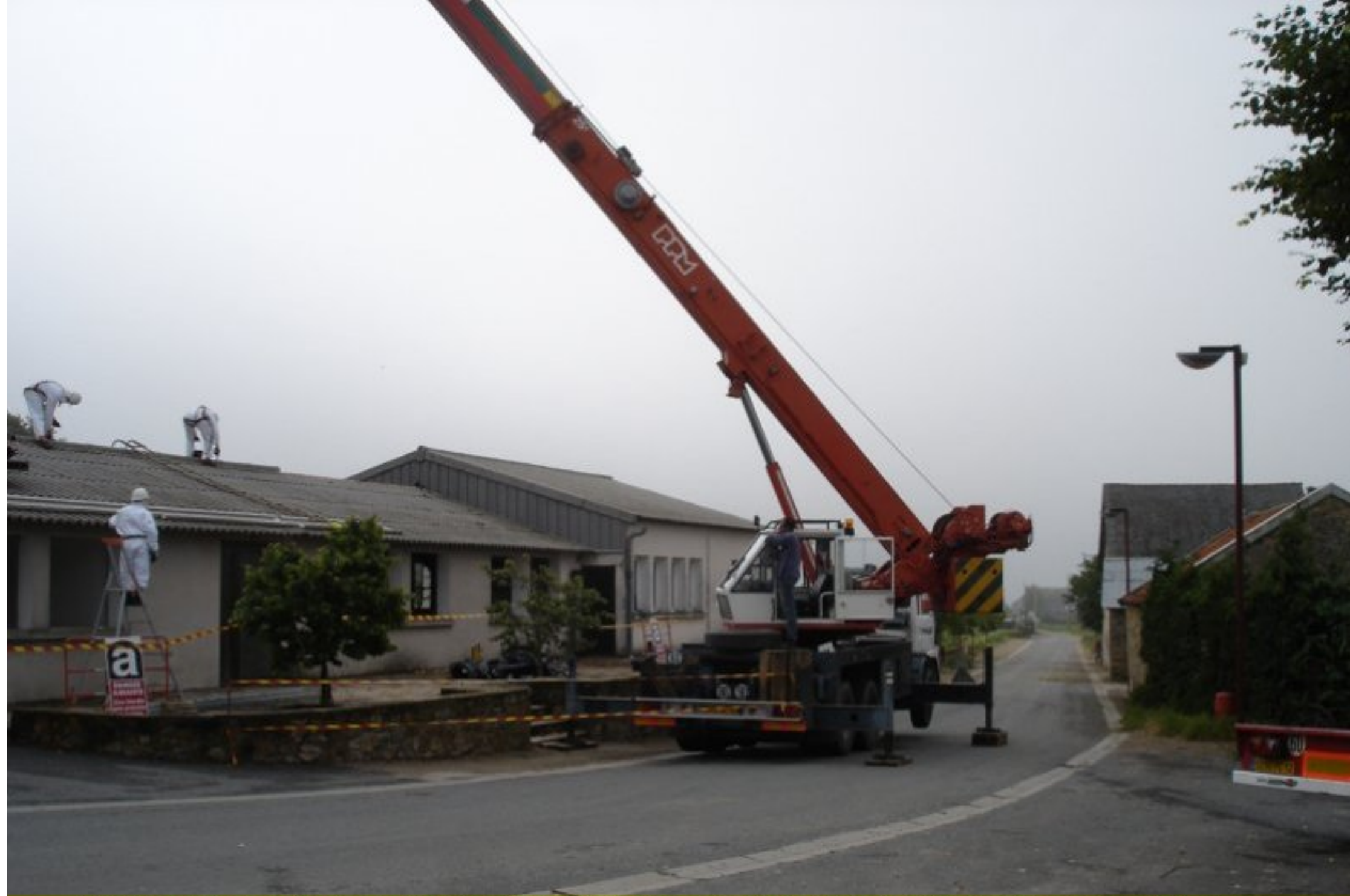
6 & 7 juin 2007: enlèvement du toit de la salle des fêtes avec les précautions liées à la présence d'amiante. Etranges images d'hommes masqués tout de blanc vêtus: des cosmonautes à Meljac !...
