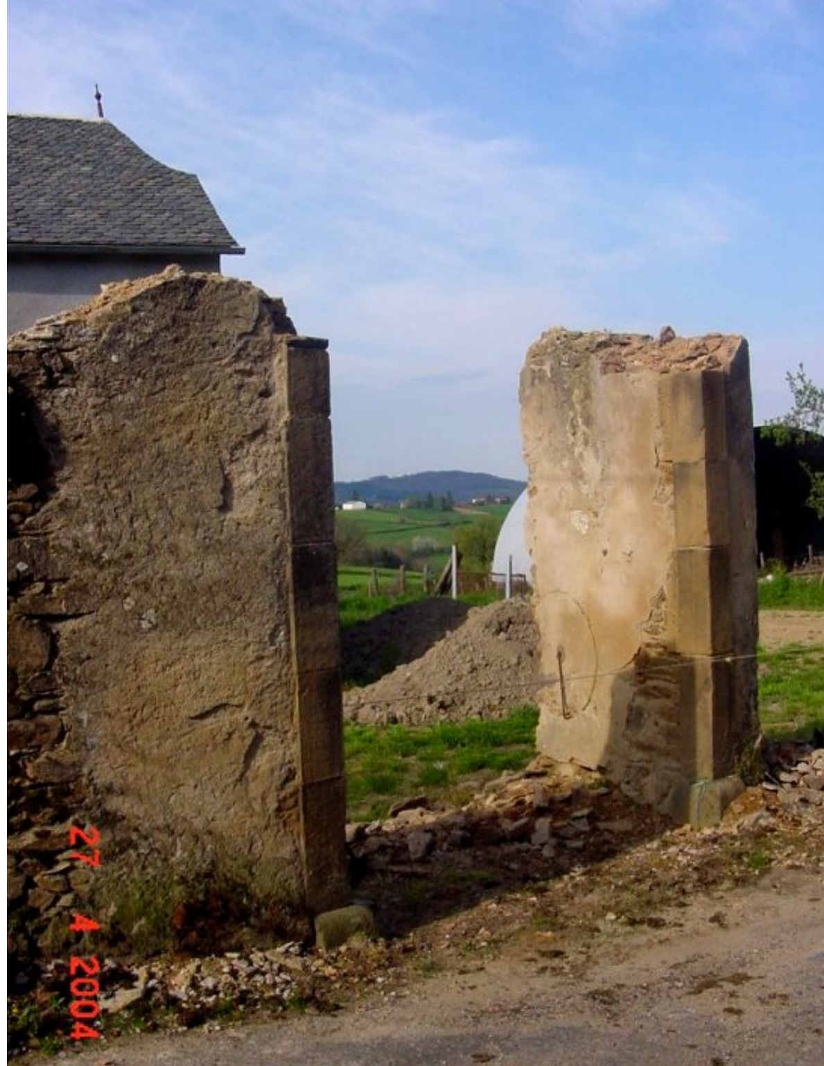
Restauration en cours de l'ancien porche de la ferme Mouly de la Tapie de Meljac
