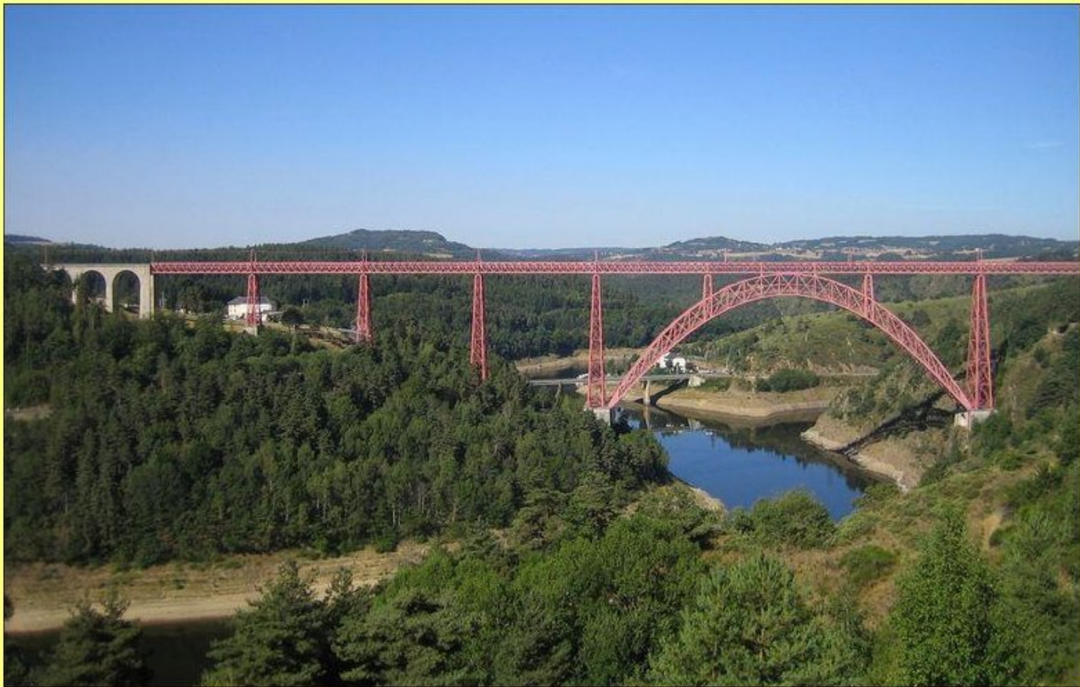
Viaduc de Garabit
