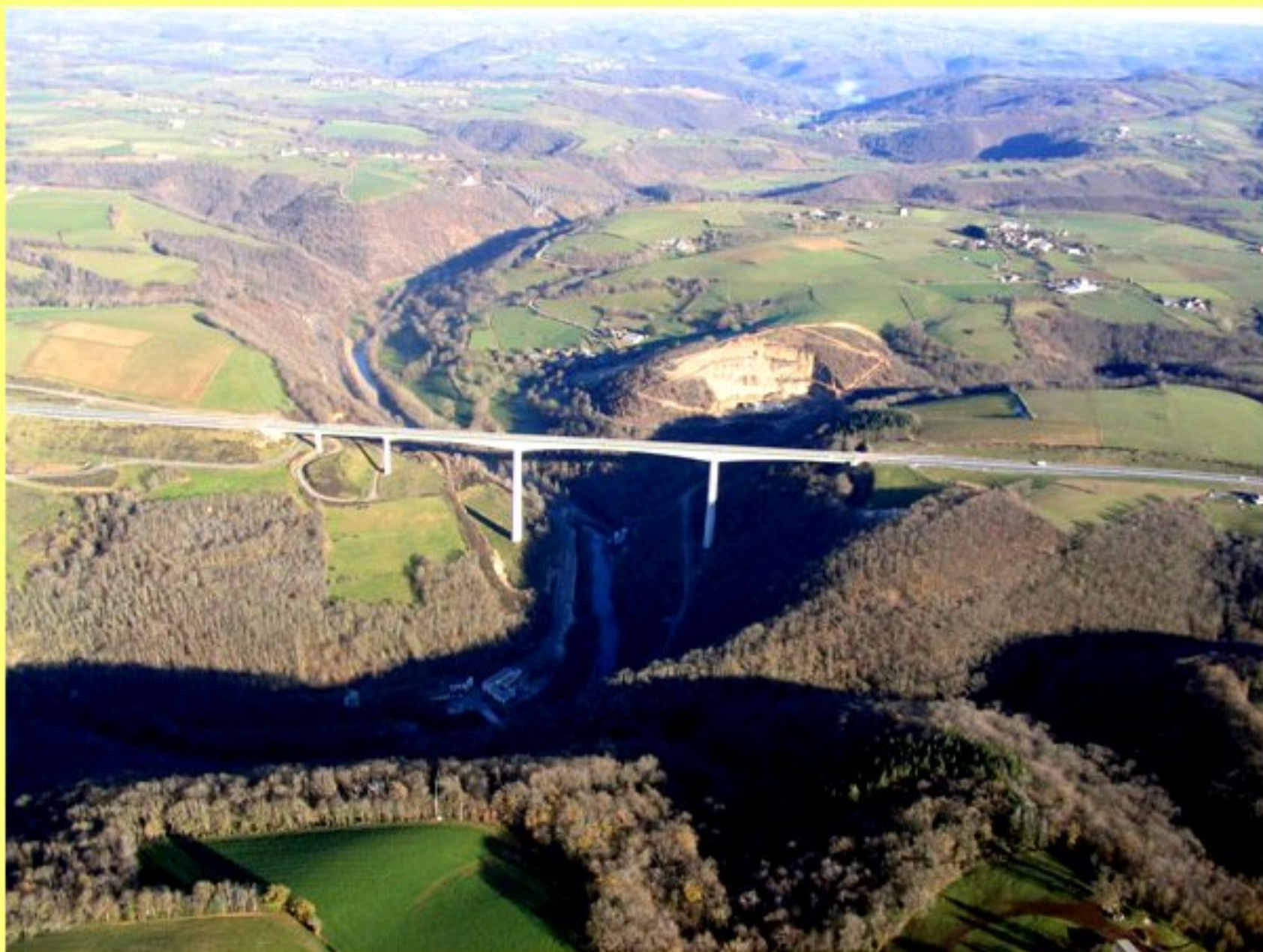
Viaduc routier du Vaur
