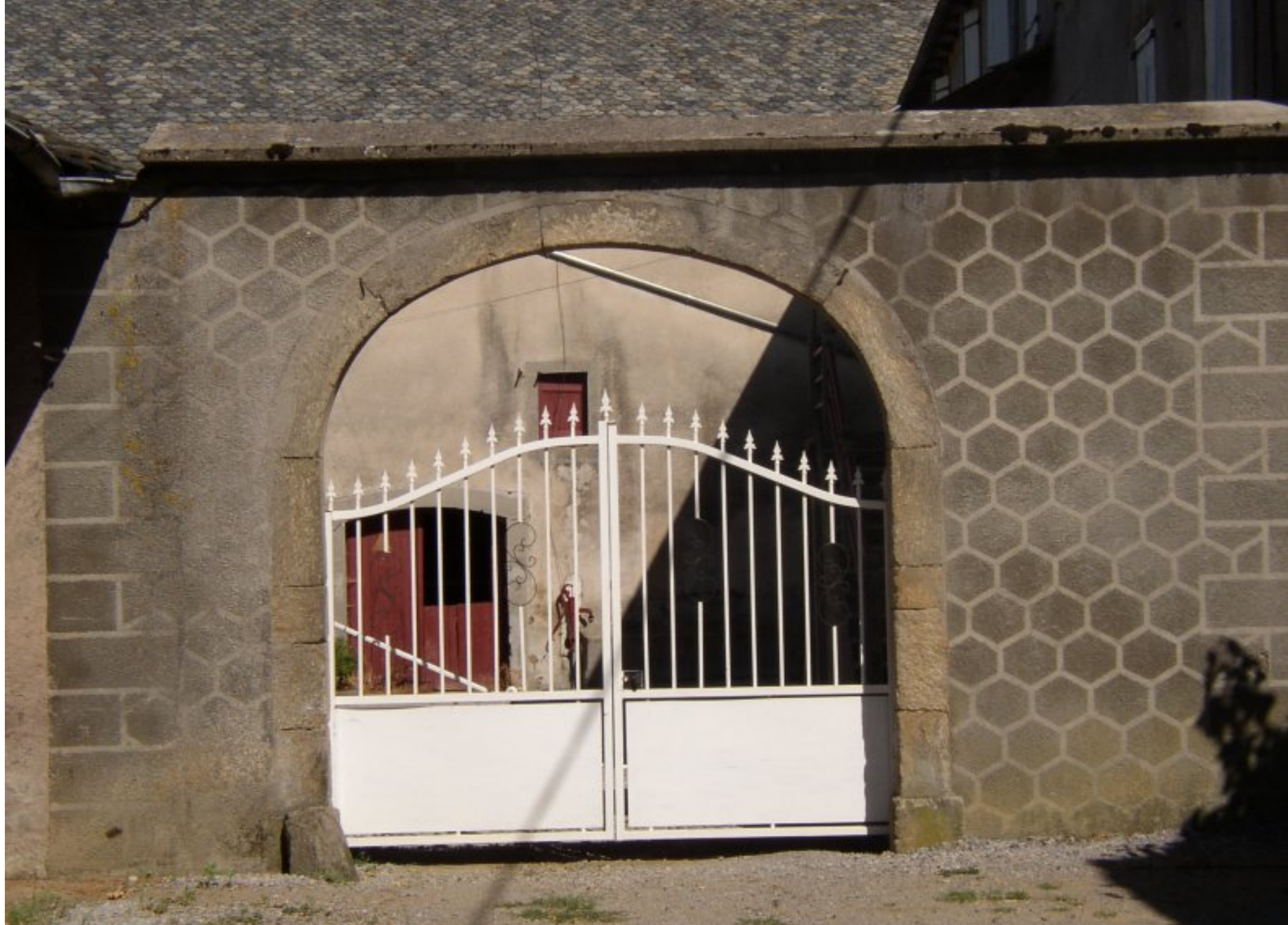
Porche de la ferme Mazars de la Bessière de Meljac
