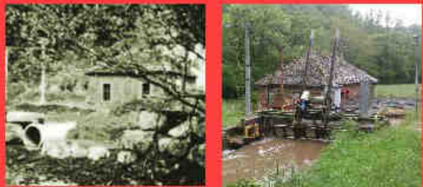
Ci-dessus le Moulin de Roumegat - L'usine électrique
