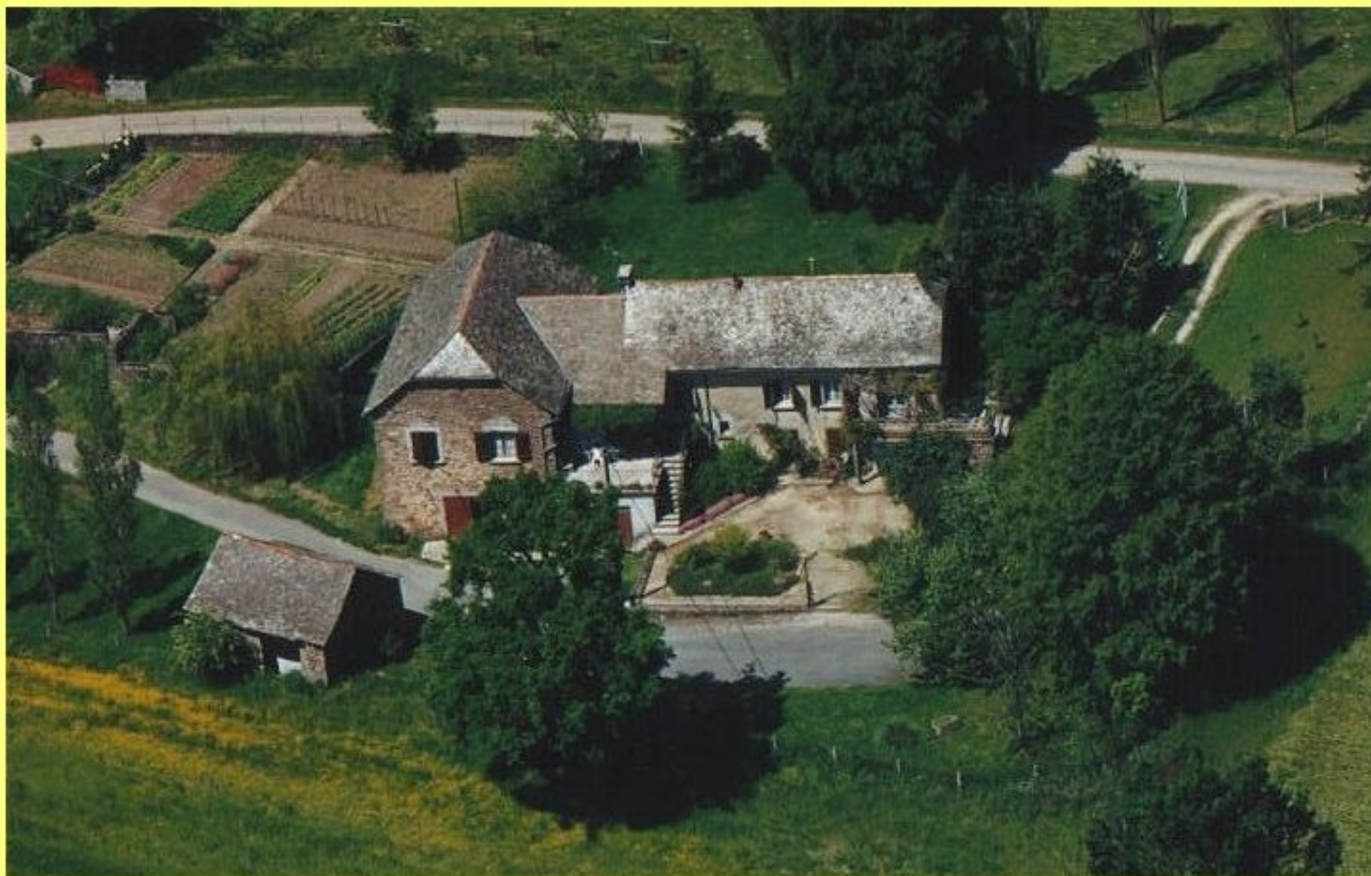
Maison Mazars - La Bessière
