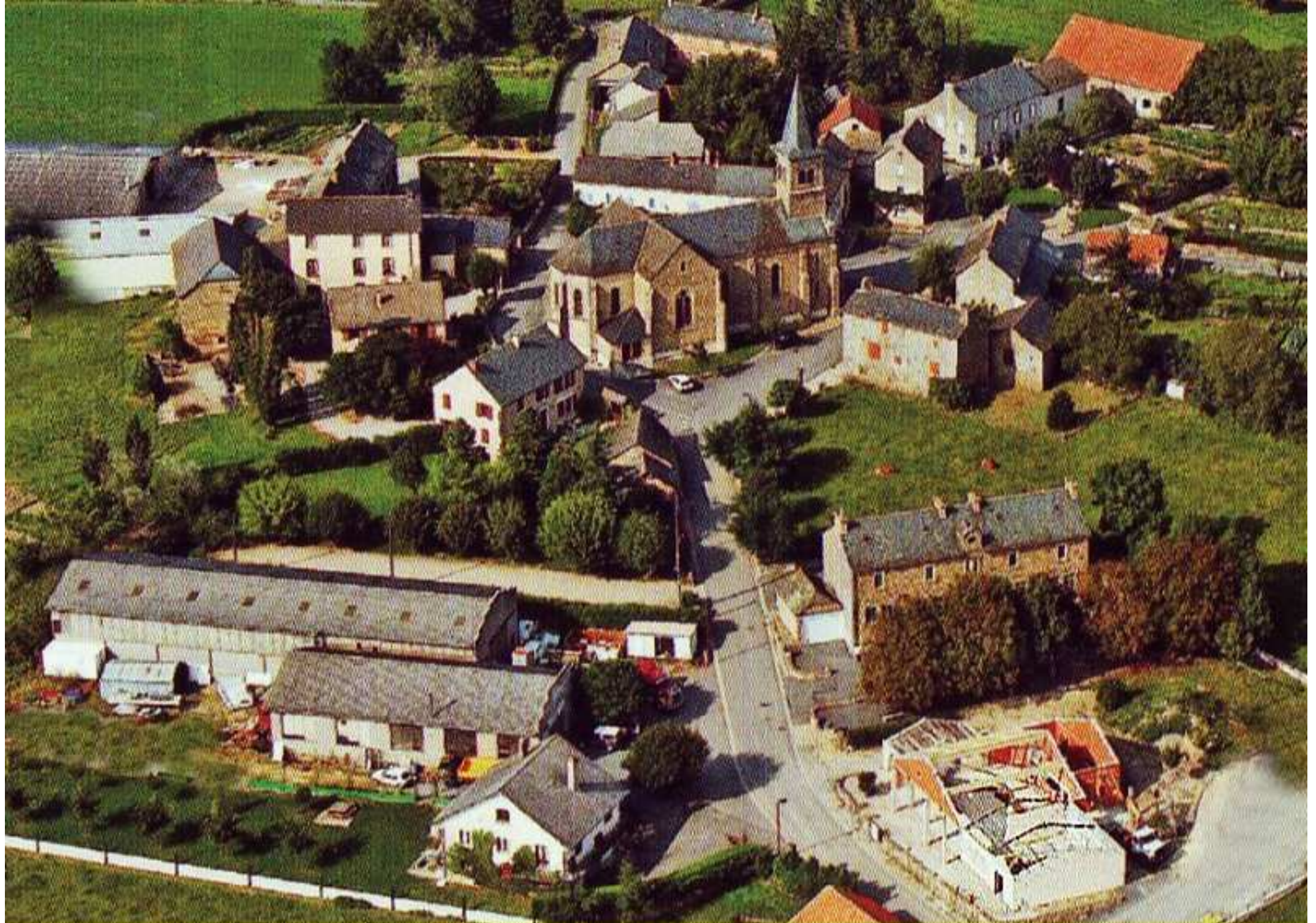
Meljac - Le Bourg - année 2007 (travaux salle des fêtes)
